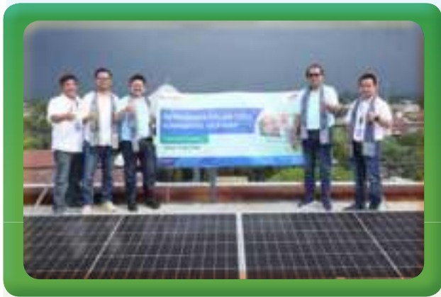
Pemasangan panel surya di FIFGROUP Cabang Cirebon pada 19 April 2022 oleh Direktur FIFGROUP, Setia Budi. Solar panel installation at the Cirebon branch office on 19 April 2022 by FIFGROUP Director Setia Budi.
